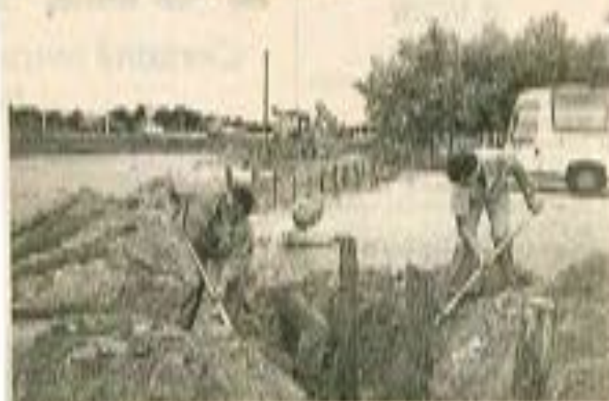
Pendant les travaux (Photo P. F. - Sud-Ouest)
