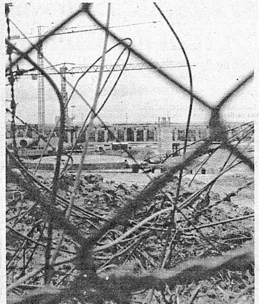
● Le Chantier de la centrale au moment des premiers travaux (Photo Jean-Michel DESTANG).
